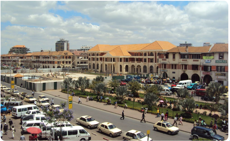
Hotel de ville en cours de finition - DMP
